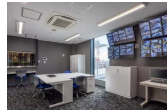
■ 防災センター
