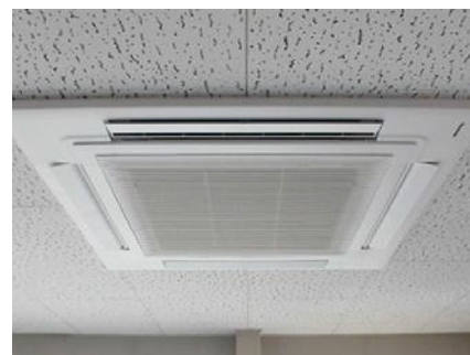
空調設備更新
